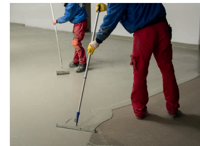
Aufbringen der Kopfversiegelung in der Fläche
