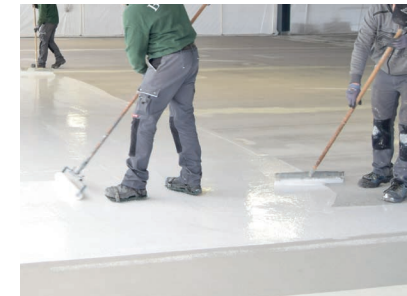
Grundierebene auf den Untergrund abgestimmte Grundierung auftragen
