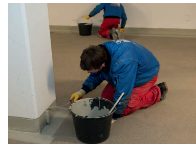
Versiegeln der Detailabdichtungen
