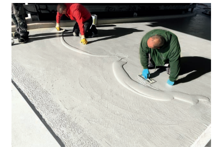
Strukturbelag als alternative Schutz- und Nutzebene
