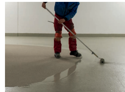
Schutz- und Nutzebene Vorlegen der Einstreulage
