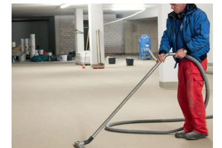
Nach Aushärtung überschüssigen Quarzsand abkehren bzw. absaugen
