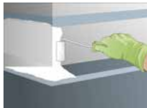
Passende Grundierung auftragen
