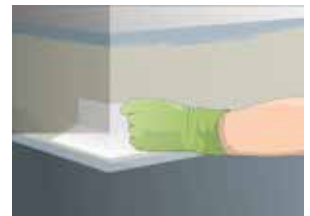
Vlies-Eckstück einbetten
