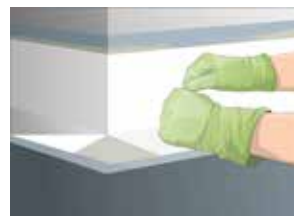
Vliesstreifen einbetten
